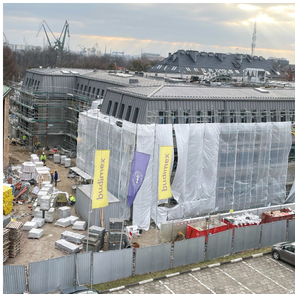
Plac budowy UCS
