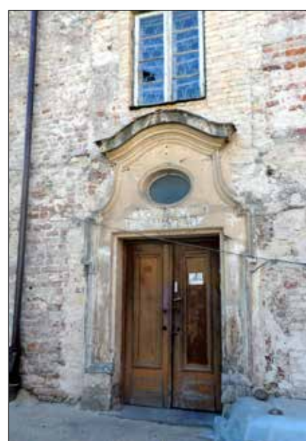
Budynek przy Franciskonu 4 – stan obecny. Tytuł własności do tego budynku odzyskał zakon franciszkański, aktualnie trwa jego remont
