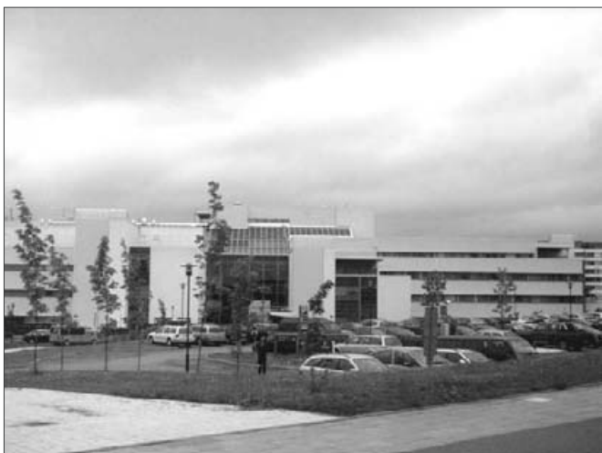
TYKS – nowy budynek szpitala w Turku
