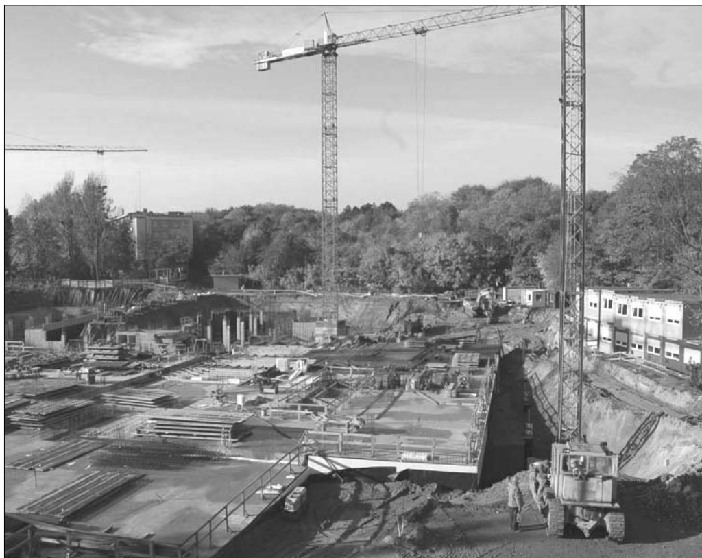
Postęp w budowie CMI – stan na dzień 20 października 2008 r.
